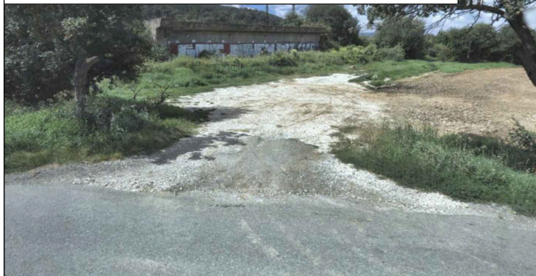
FOTO - DETAIL VÝJEZD VOZIDEL STAVBY
